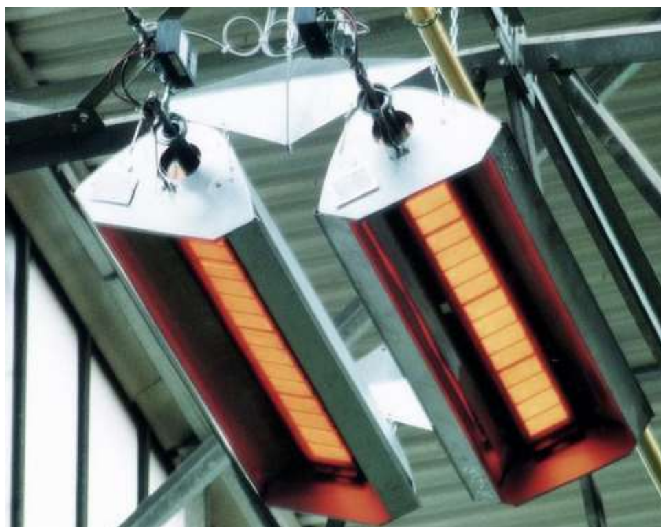
Figure 110 : Example for radiant luminous heater [source: GoGaS Goch GmbH & Co. KG, Zum Ihnedieck 18, 44265 Dortmund].
