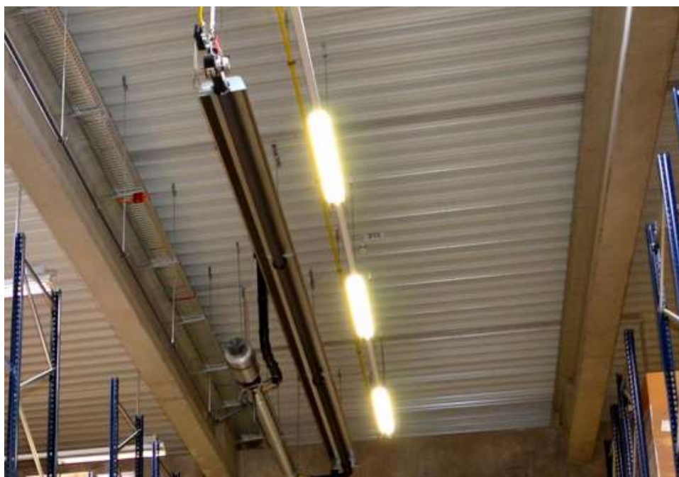
Figure 109 : Example for radiant tube heater [source: GoGaS Goch GmbH & Co. KG, Zum Ihnedieck 18, 44265 Dortmund].
